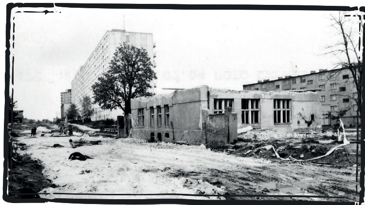
Asanácia budovy - začiatok 70. rokov
