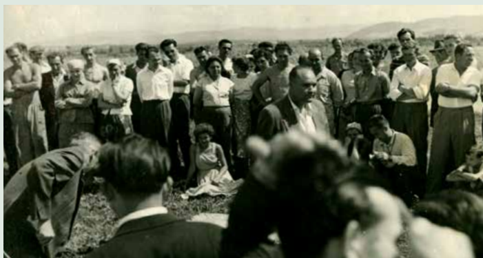
■ Prvý výkop - výstavba sladovne
